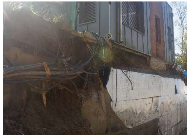
공사 중 현황 전경[2024년 하반기 정밀]
