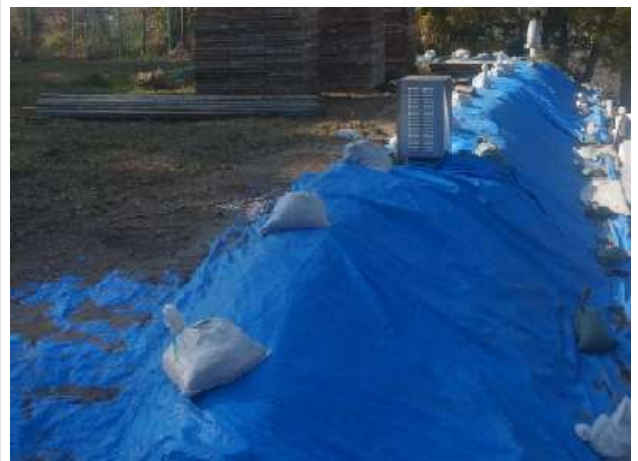
공사 중 현황 토사 정비 중[2024년 하반기 정밀]
