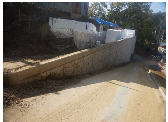
공사 중 현황 옹벽 재시공[2024년 하반기 정밀]
