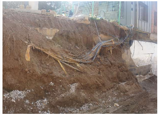
공사 중 현황 토사 굴착 및 반출[2024년 하반기 정밀]
