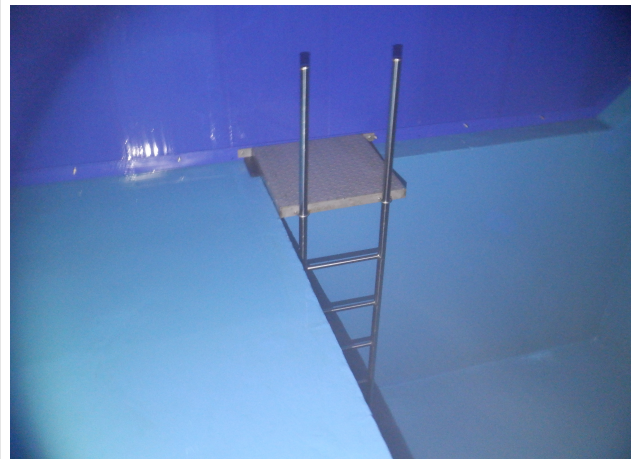
항내 집수정 진입 사다리 설치 현황
