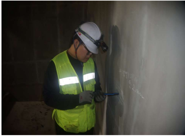
탄산화 깊이 측정
